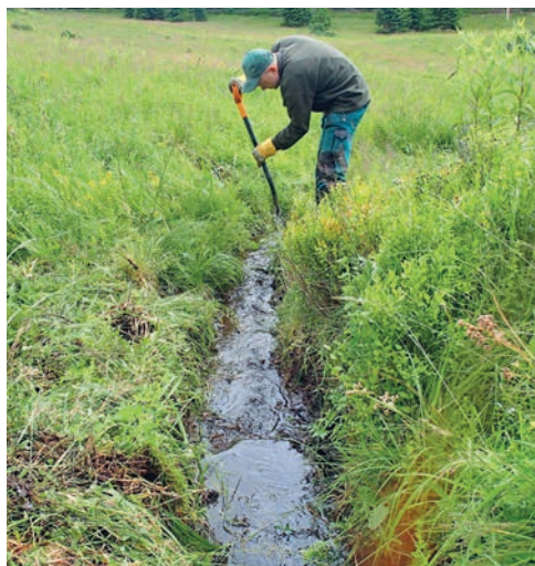
Obr. 3. Ruční technologie při tvorbě stružek.
