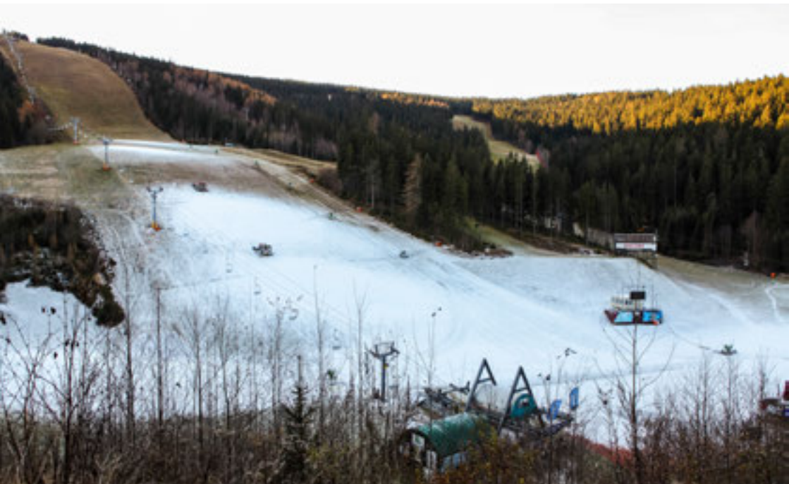
Zasněžování sjezdovek v EVL Krkonoše
